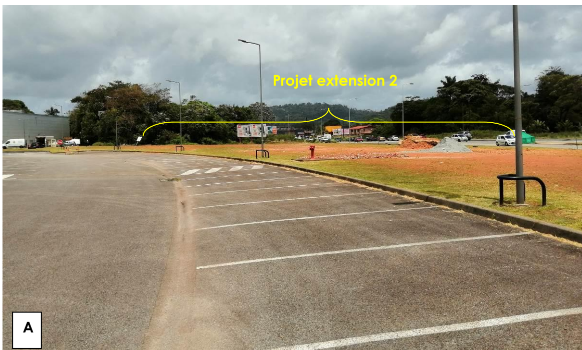
Figure 1 : Vue rapprochée depuis le parking existant de l'emplacement de l'extension 2
